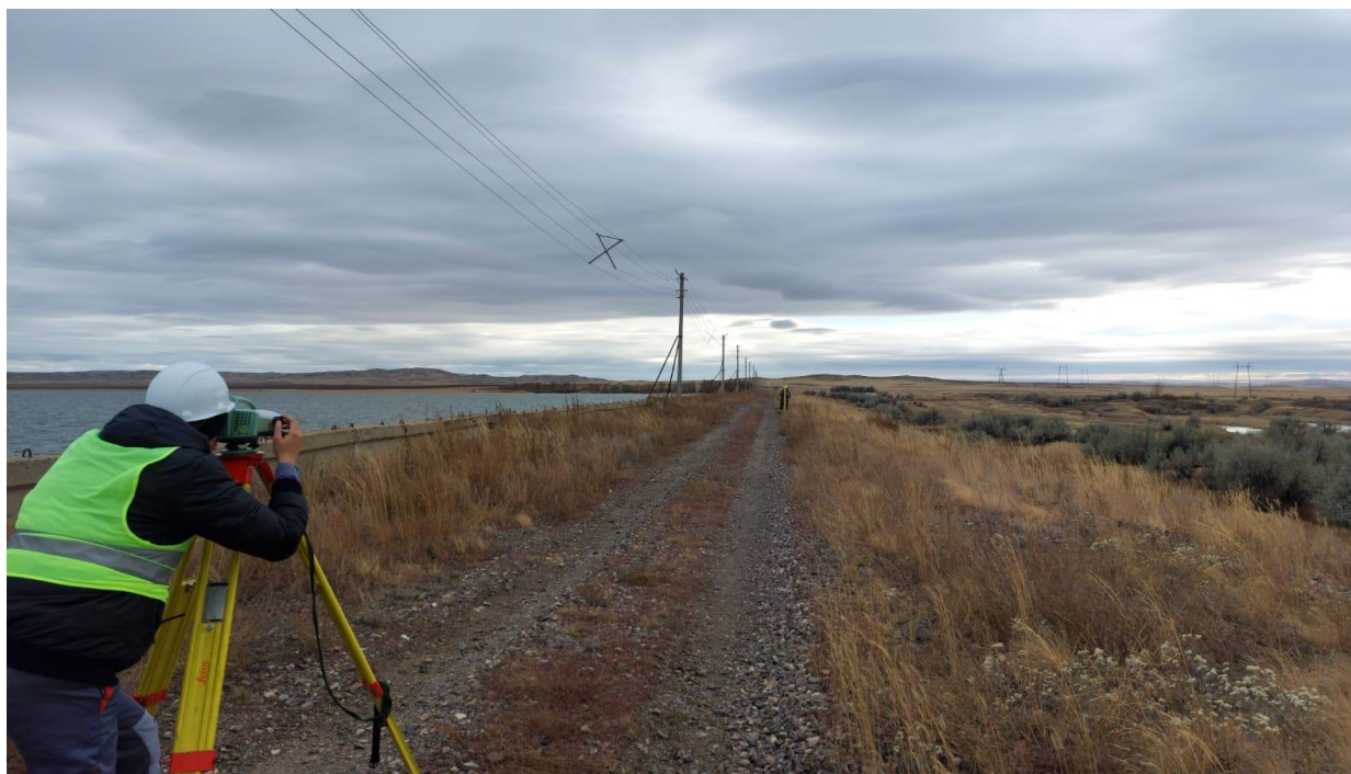
Рисунок 2 – Выполнение высокоточного нивелирования земляной плотины
