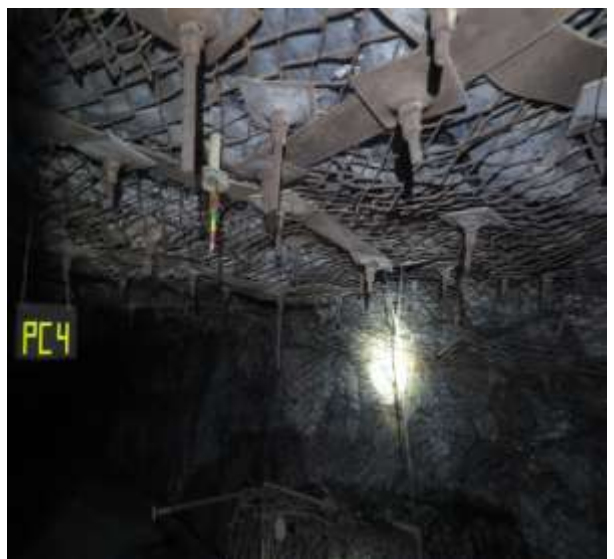
Сурет 2.1 – Аралас бекіту кезінде жанасқан қазбалардың жиектерінің деформациясы
