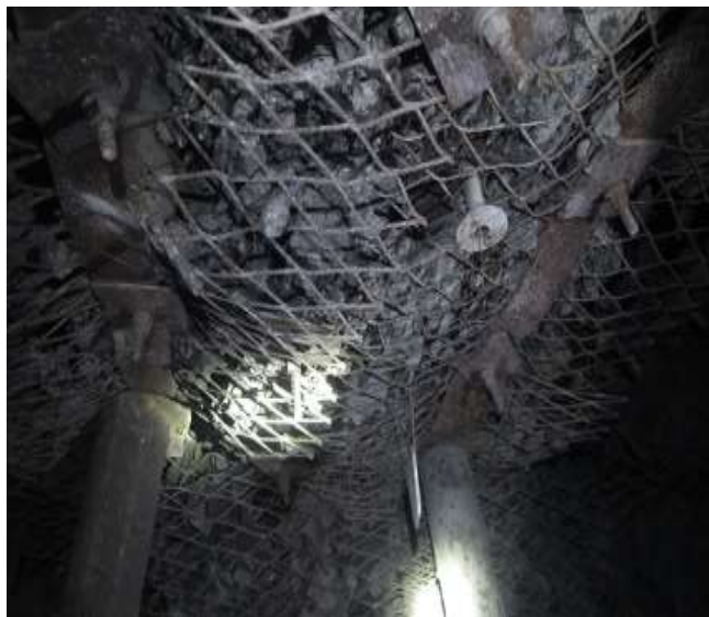
Сурет 2.1 – Аралас бекіту кезінде жанасқан қазбалардың жиектерінің деформациясы
