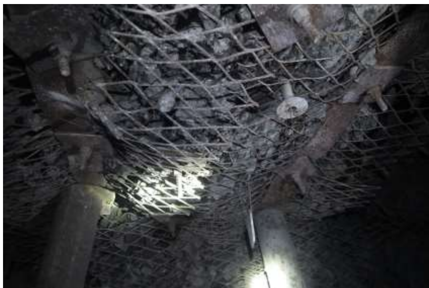
Сурет 2.10 – Төбе таужыныстарының майысуымен бір деңгейлі қарнақтық бекіту кезінде төбеге арналған бекіту құрылымы
