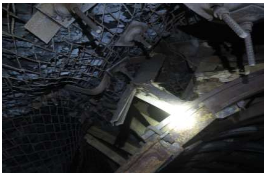
Сурет 2.11 – Қарағанды көмір бассейні «Шахтинская» шахтасының жағдайына тән қазбаның аралас бекітпесі (күмбезделумен)
