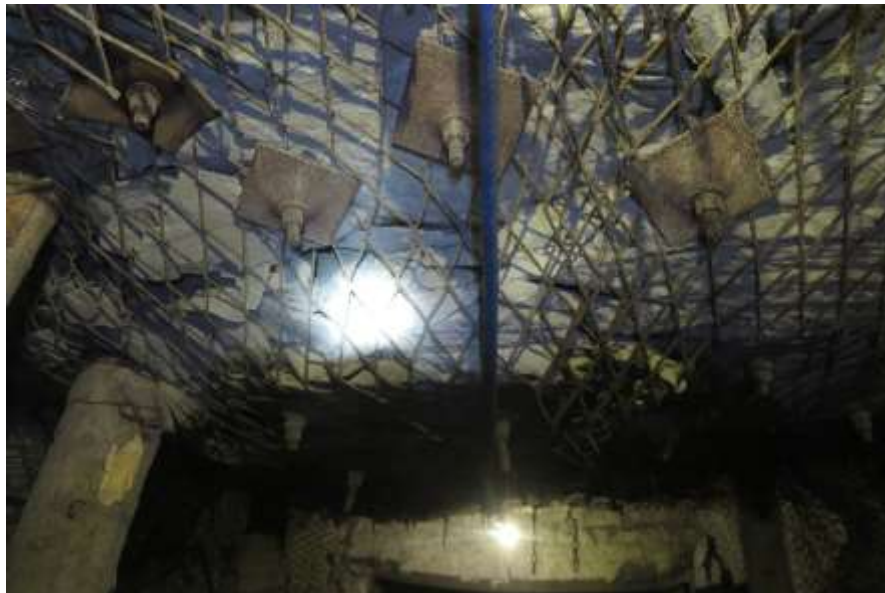
Сурет 2.16 – «АрселорМиттал Теміртау» АҚ ҚД «Шахтинская» шахтасының 14д1-2 жанасқан желдету штрегінің төбе таужыныстары және бүйірлік жиектері жағынан деформациялары
