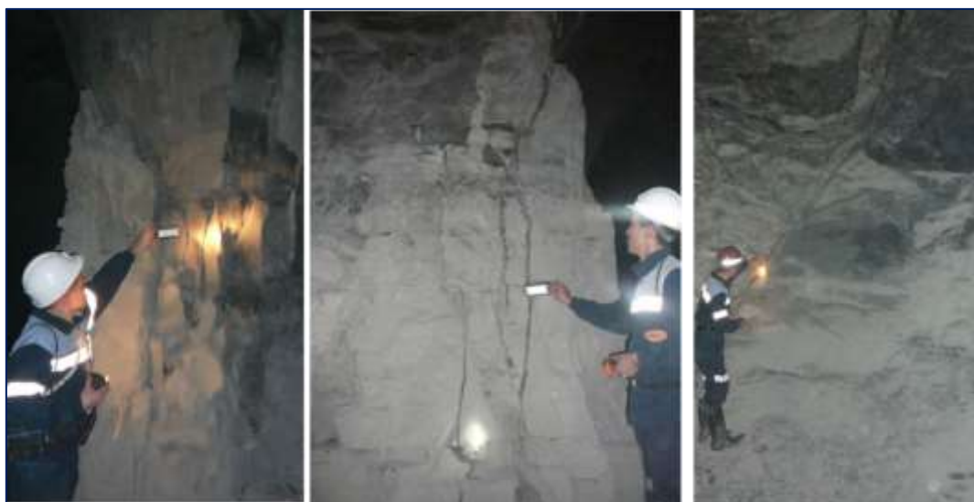
Рисунок 2 – Обследование очистных выработок и целиков на рудниках
